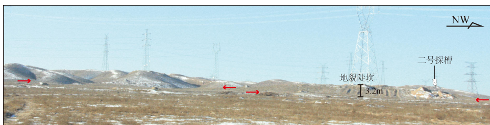
图 7 青铜峡火车站西柳木高断裂线性地貌陡坎
