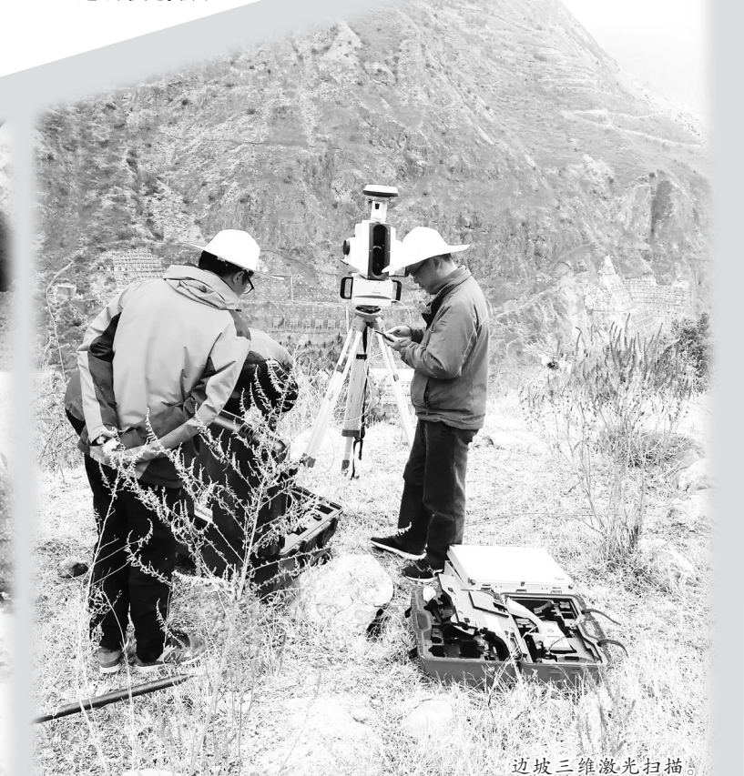
边坡三维激光扫描。
